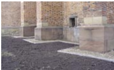
Kościół w Drohobyczu (Ukraina) – instalacji systemu osuszania towarzyszyły prace w zakresie odwodnienia powierzchniowego
