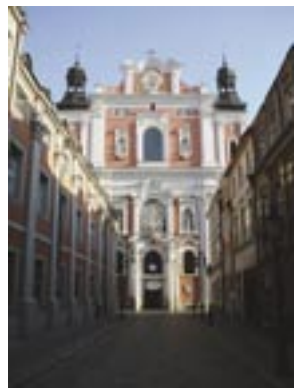
Kościół farny w Poznaniu – instalację systemu osuszania poprzedziły badania wilgotności murów.
