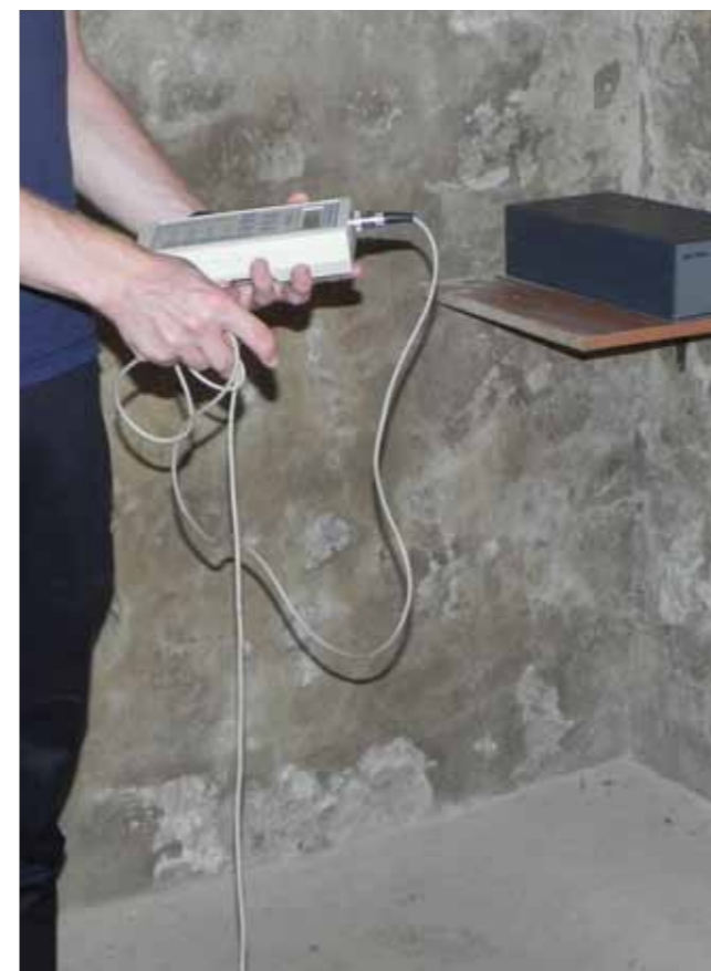
Pomiar natężenia ziemskiego pola magnetycznego. W głębi aparat Mur-tronic MT300
