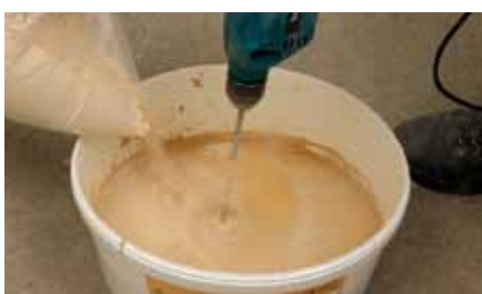
Wymieszać zawartość wiadra z wodą
